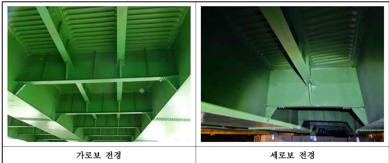
【사진 4.3.6】 가로보 및 세로보 전경
