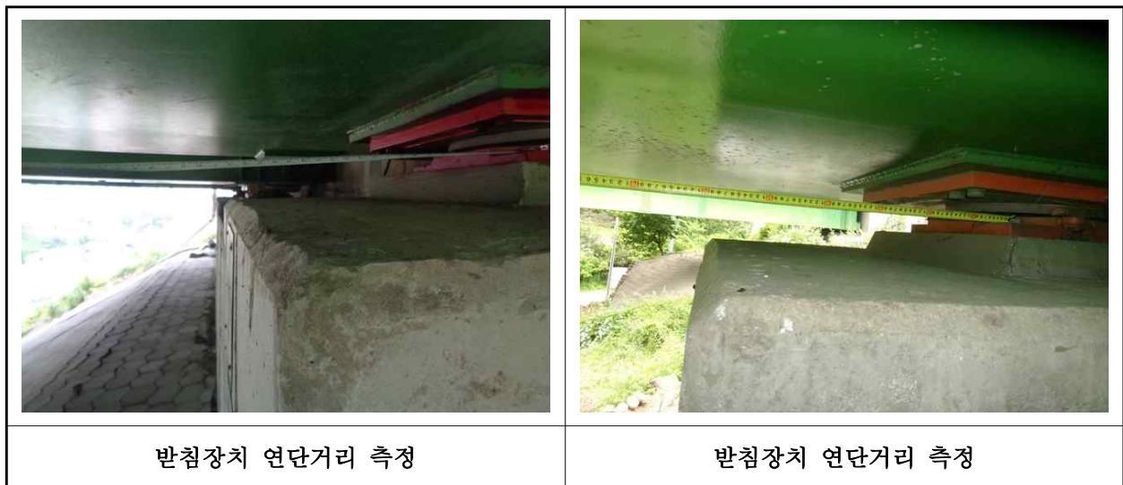
【사진 4.3.14】 교량받침장치 연단거리측정
