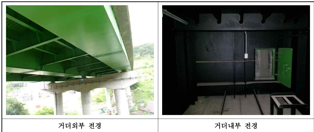
【사진 4.3.4】 거더 전경
