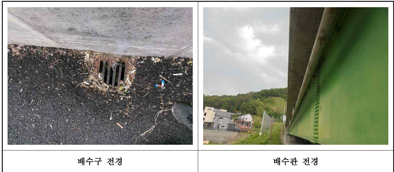
【사진 4.3.21】 배수시설 전경
