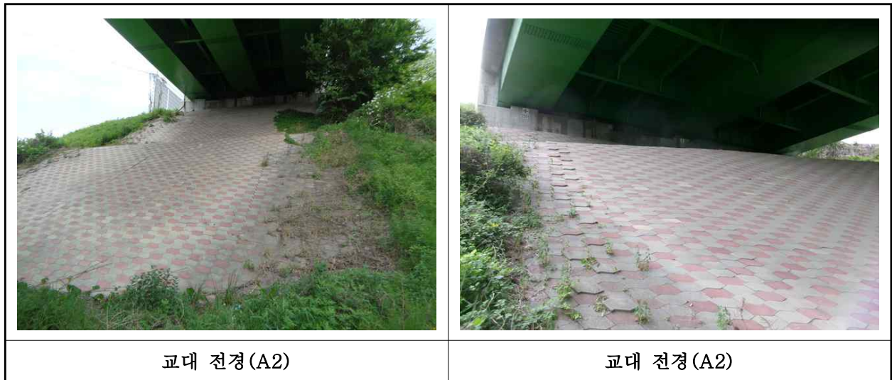
【사진 4.3.8】 교대 전경
