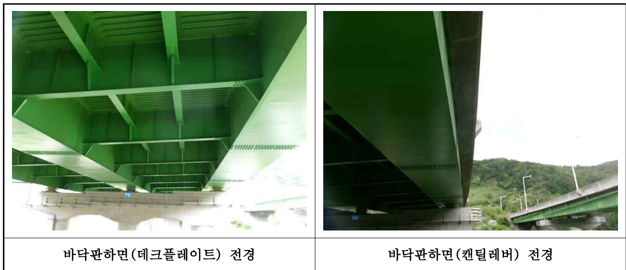
【사진 4.3.2】 바닥판하면 전경
