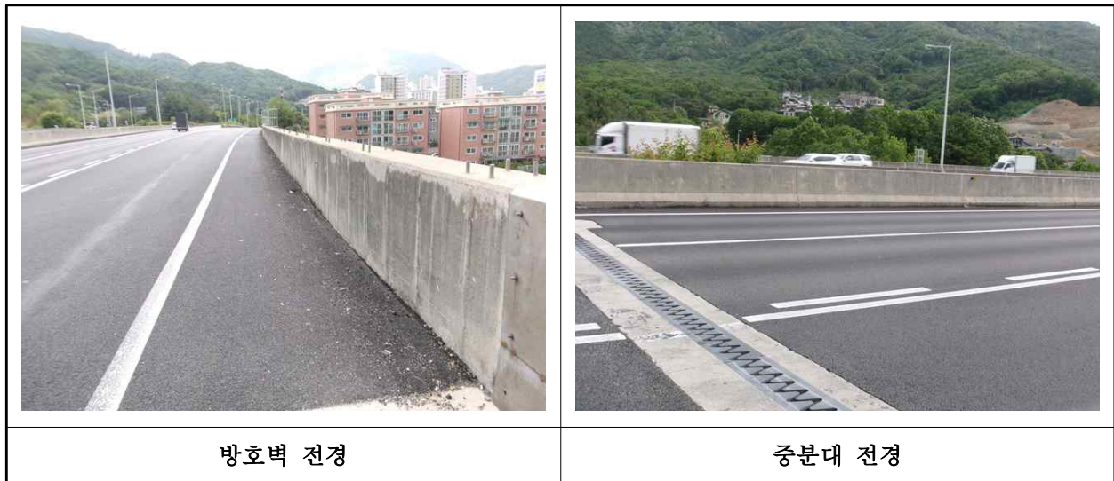
【사진 4.3.23】 방호벽 및 중앙분리대 전경
