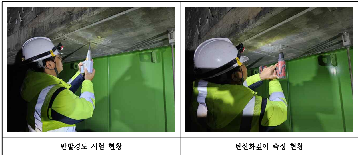
【사진 4.4.1】 콘크리트 내구성조사 현황
